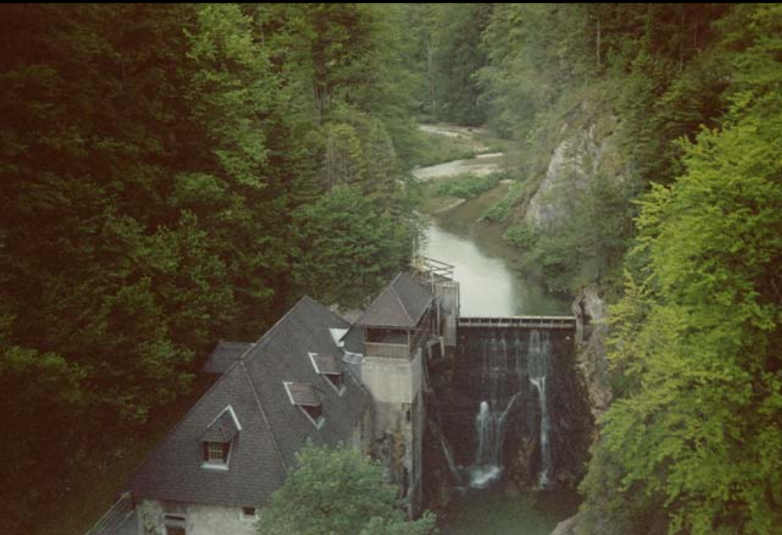
Prítok Salzy těsně před ústím Feeder of the Salza immediately before mouth Dopływ Salzy bezpośrednio przed ujściem
