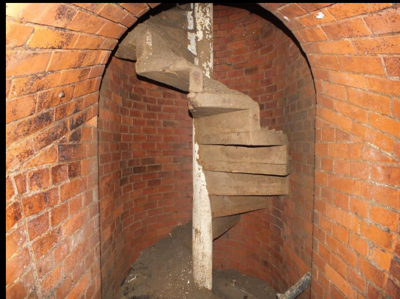
Stará čistírna odpadních vod
