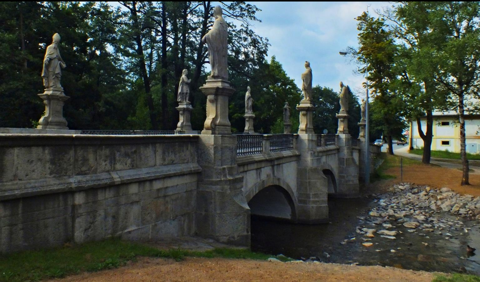
Žďár n. Sázavou (1761) Barokní kamenný most Baroque stone bridge Barokowy most kamienny
