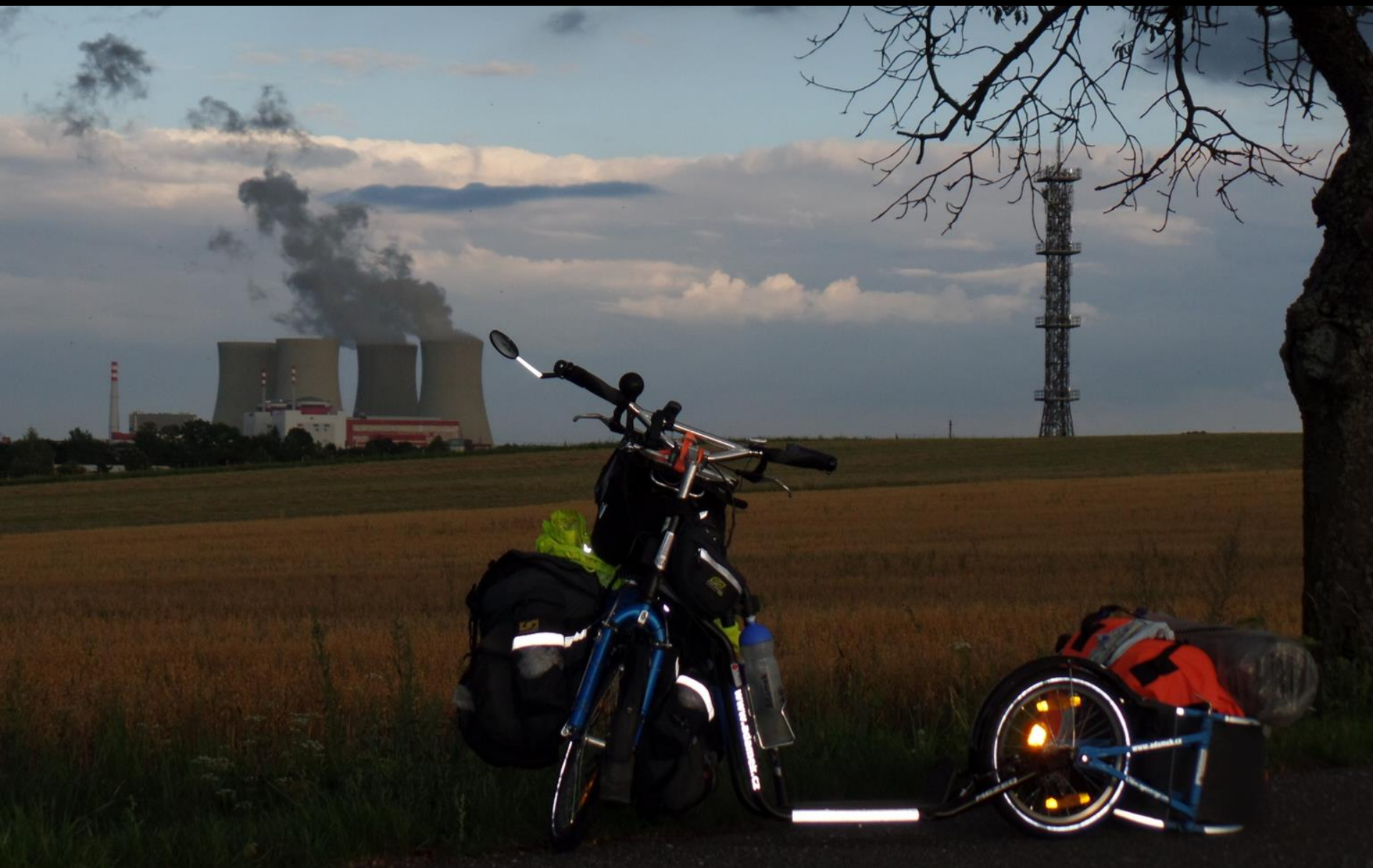
Jaderná elektrárna Temelín Temelín Nuclear Power Plant Elektrownia Jądrowa Temelín
